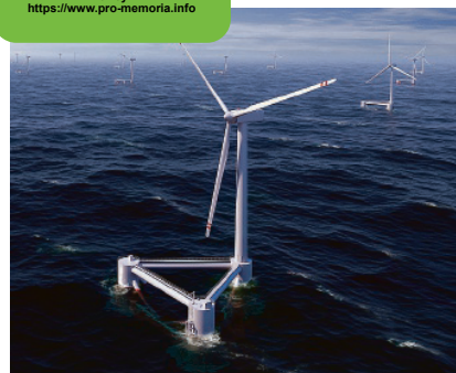
INNOVAZIONE Le pale eoliche galleggianti installate nel mare [Ansa]
