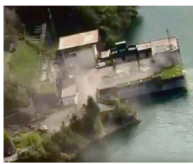
DISASTRO La centrale nel bacino di Suviana
